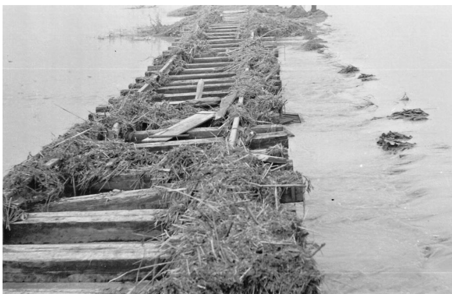
Poškozená trať Čejč - Ždánice
